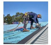
Se instala en los aleros y las inclinaciones para reducir el riesgo de voladura de tejas
