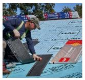
Fácil de separar las hiladas por la mitad, con el diseño preperforado
