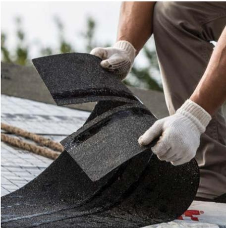
Se parte por la mitad fácilmente a lo largo de la perforación para una fácil instalación
